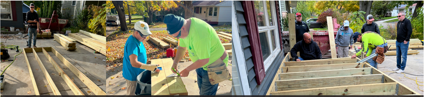
Fotos de izquierda a derecha: Cal Conway, aprendiz del Local 314, con una sección de la rampa que enmarcó; El representante comercial del Local 314, Scott Watson (R) y Joe Herr, fundador de Logan's Heart & Smiles, miden y marcan algunas tablas para la rampa; El representante empresarial del Local 314, Mike Higgins (izq.) y el aprendiz Josh Dodge (derecha, en alta visibilidad), trabajan en el marco de algunas escaleras al final de la plataforma enmarcada.
