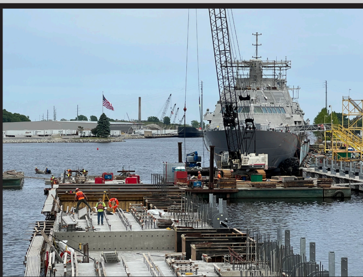
Foto del elevador naval de Fincantieri en construcción.
