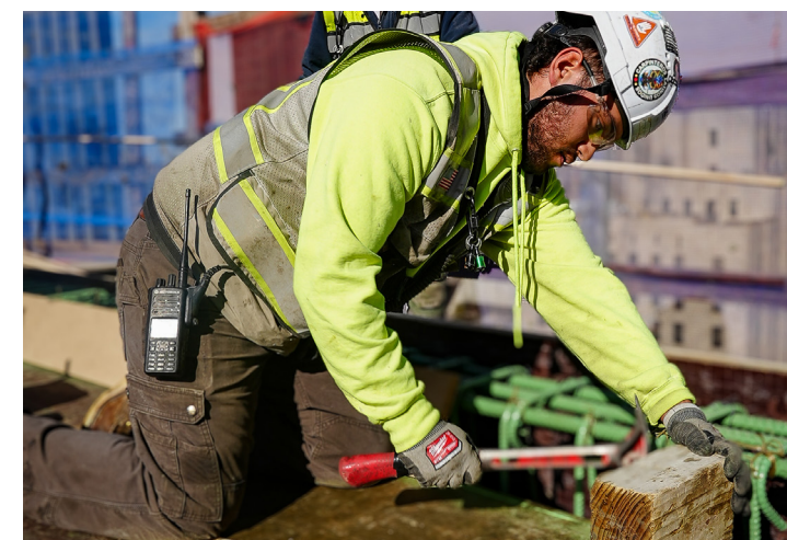
Diego Kyndt (Local 427 - Omaha, NE) instalando encofrado de borde.
