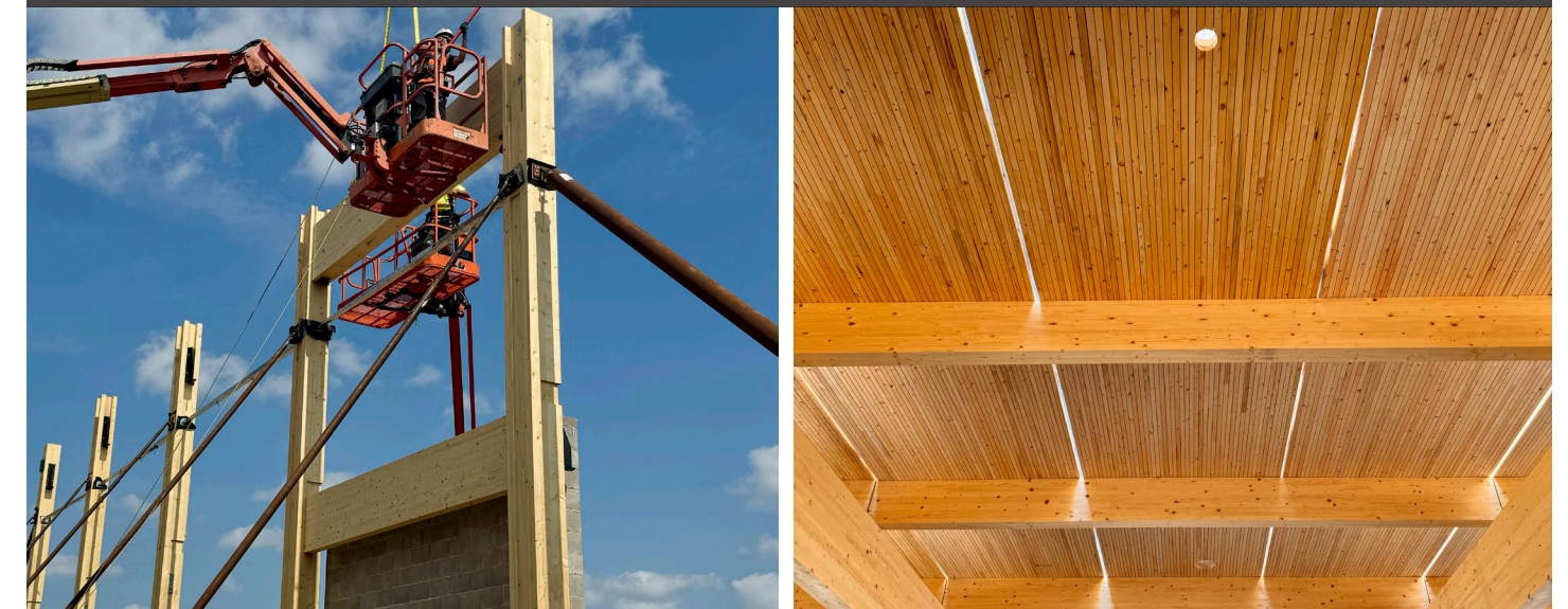
Miembros que trabajan en la construcción de la estructura de madera maciza para el centro de servicios en el condado de Washington, MN.
